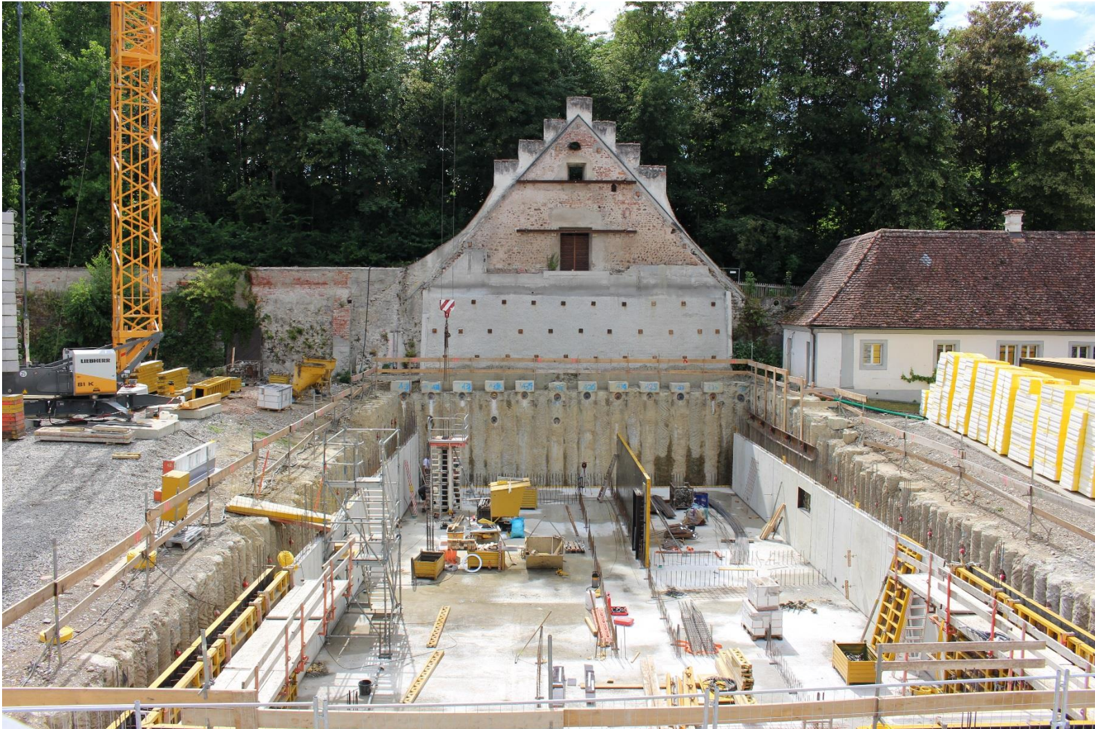
Juni 2018 – die Bodenplatte ist fertig
