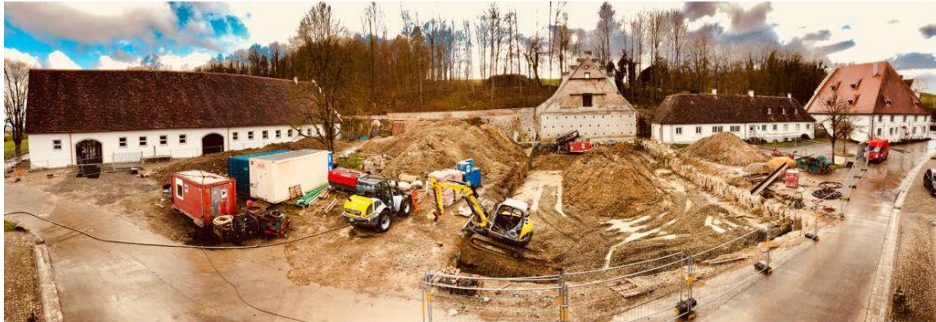
April 2018 – Baugrube wird ausgehoben
