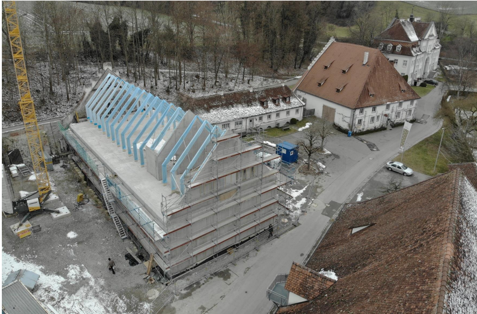
Januar 2019 – Das Dach entsteht
